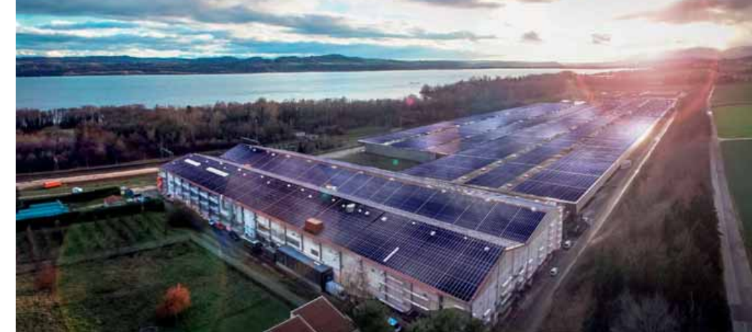
Instalación fotovoltaica más grande de Suiza realizada por Soleol en Onnens: 31,000 paneles, 55,000 m 2 , 8.5MW. Abastece la electricidad a 2,500 casas.
