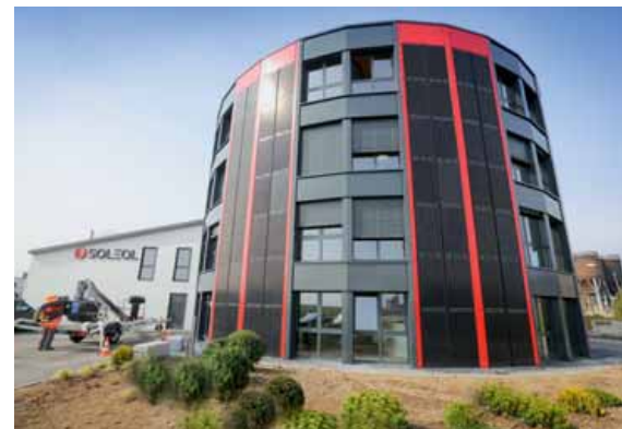
El nuevo edificio de la empresa Soleol en Suiza, con las últimas tecnologías, único en Europa. El costo de la construcción fue de 6 millones de dólares.
